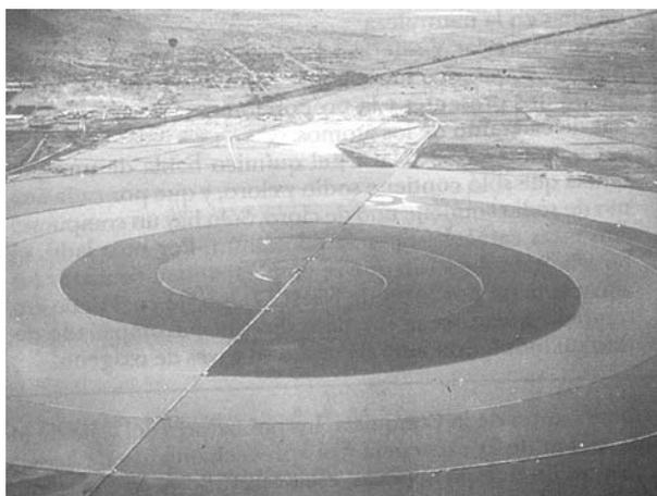
**Fig. 8.** El “caracol”. Las aguas del lago de Texcoco siguen siendo aprovechadas hoy para obtener carbonato de sodio. Como primer paso, la industria Sosa Texcoco empleaba un enorme evaporador solar, ¡de 800 hectáreas!, que concentraba en sales las aguas extraídas del subsuelo [5].
