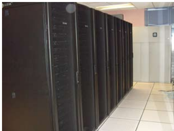
Foto 4. Cúmulo de 2160 procesadores conocido como Aitzaloo, ubicado en el Laboratorio de supercómputo y visualización.
