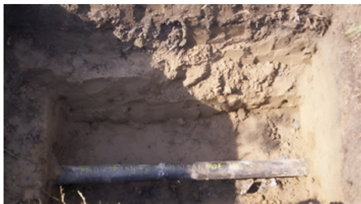
Figura 3. Aspecto de una tubería al ser desenterrada. Fuente: elaboración propia.
